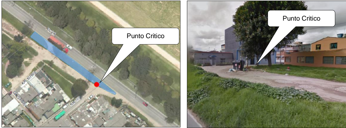
Ilustración 33 . Ejemplo separador con punto crítico que si requiere barrido
